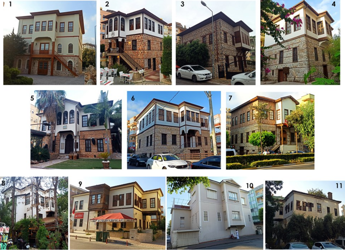
Görsel 2. Alanya kale Surları Dışında İncelenen 11 adet konak yapısı
