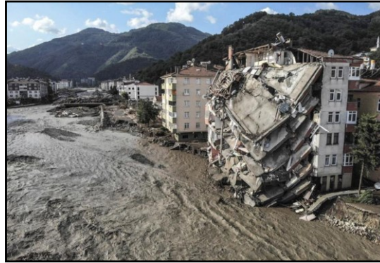
Şekil 3. Kastamonu'nun Bozkurt ilçesinde sel ve toprak kaymalarında onlarca kişinin hayatını kaybetmesinin ardından yıkılan binalar ,13 Ağustos 2021, Cuma. (Fotoğraf: İsmail Coşkun/ İHA)
